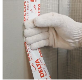
Рис. 12. Проклейка примыканий пароизоляции к стенам и окну
