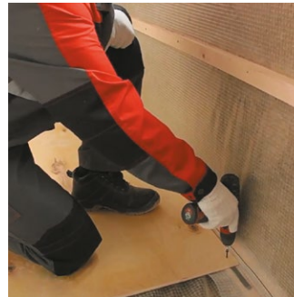
Рис. 13 . Установка покрытия пола
