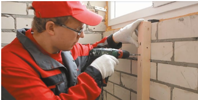
Рис. 1. Установка вертикального каркаса под теплоизоляцию
