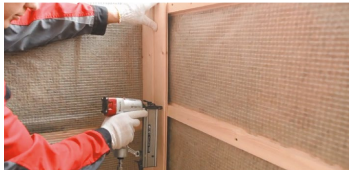
Рис. 7. Устройство внутренней обшивки
