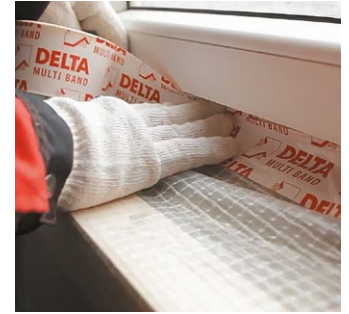
Рис. 12. Проклейка примыканий пароизоляции к стенам и окну
