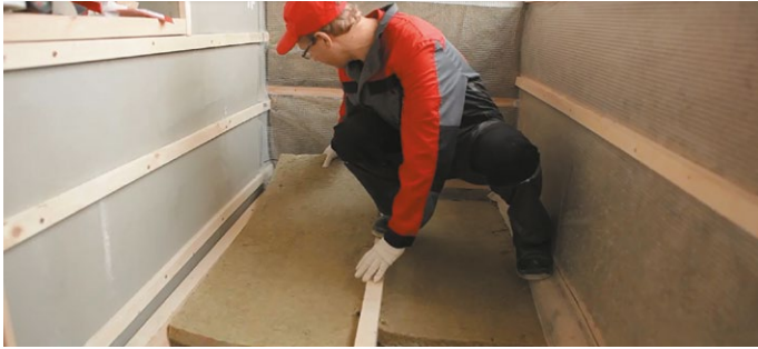
Рис. 9 Укладка теплоизоляционных плит
