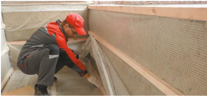
Рис. 10. Монтаж пароизоляционной пленки
