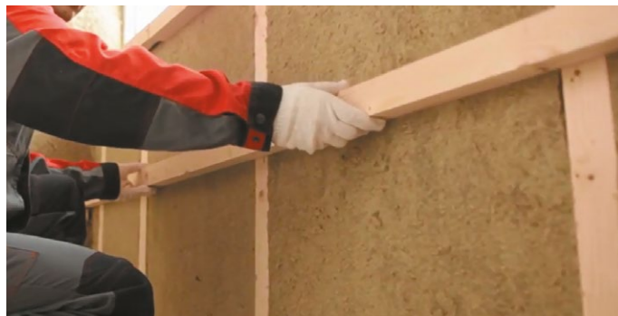
Рис. 3. Установка горизонтального каркаса под теплоизоляцию
