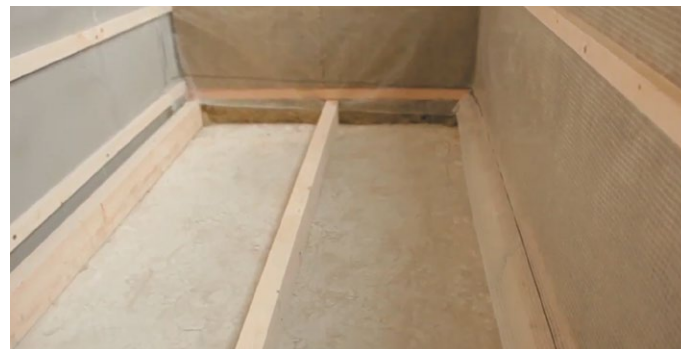
Рис. 8. Монтаж деревянных лаг на пол
