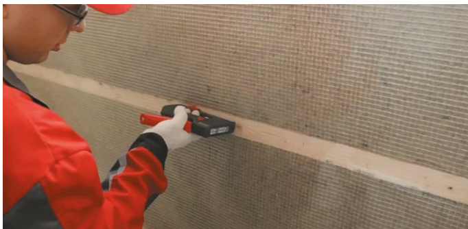
Рис.5. Монтаж пароизоляции
