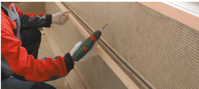
Рис. 6. Монтаж контррейки
