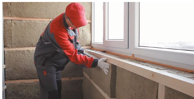
Рис. 4. Укладка плит теплоизоляции второго слоя
