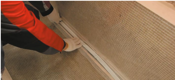
Рис.11. Проклейка нахлестов пароизоляции
