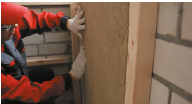
Рис. 2. Укладка плит теплоизоляции первого слоя
